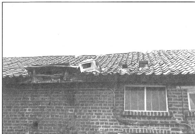
5. Het speelberd met de plank, waar de duiven binnenvallen, de kijker of de loer, de enkele en de dubbele open pan van het zolderhok te Rotselaar (Foto Richard De Cuber).
